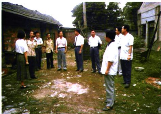
1994年，市政府领导、市公安局领导，在南区公安分局领导陪同下，到七一路派出所建筑工地现场办公。
