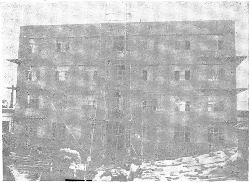
建设中的中医院
