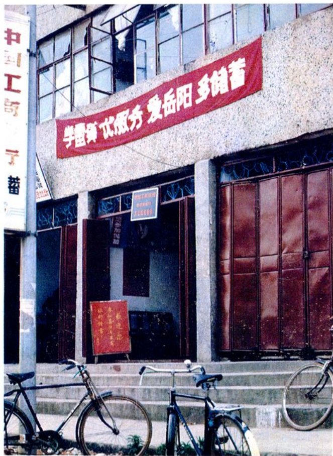
文艺路储蓄所
