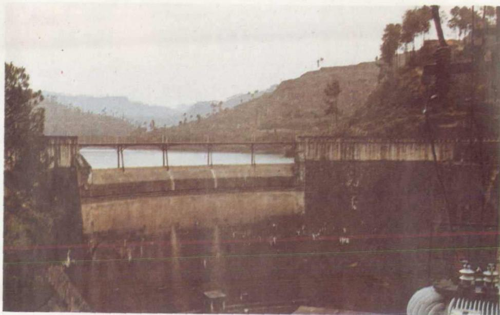
沙滩河水库，1974年动工至1978年建成，库容量2,830万立方米，控灌农田10万余亩，是一座以蓄水灌溉为主，结合发电、养鱼综合利用的中型水库。图为水库堤坝。
