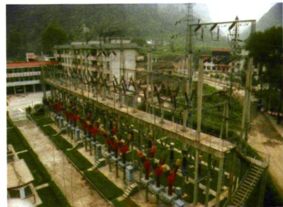
车坝三级电站厂区外景
