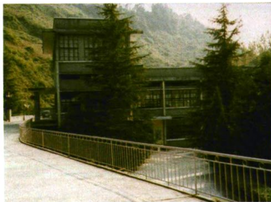
车坝二级电站机房外景
