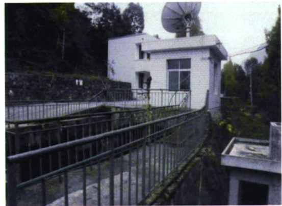
车坝三级电站前池
