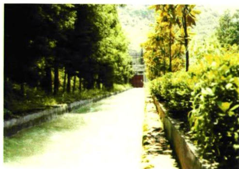
公司发电引水渠道
