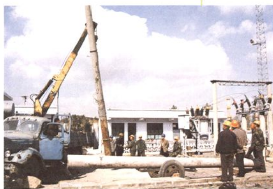
∧ 岭上变电站改造工程施工现场
