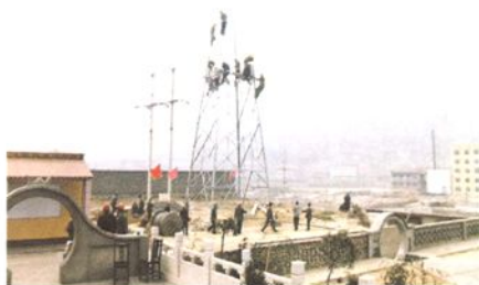
∧ 1998年城关变电站进线双回路铁塔施工现场
