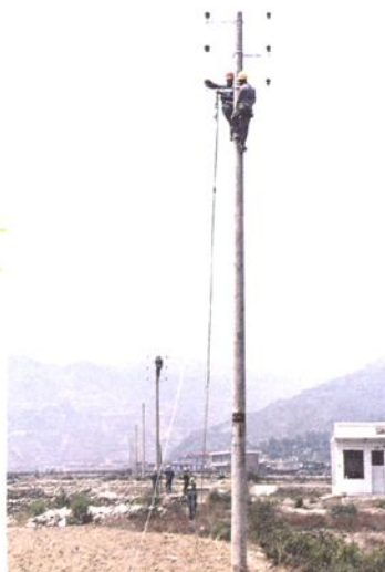
∧ 农网改造放线施工现场
