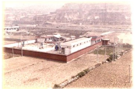
》 光华35千伏变电站
