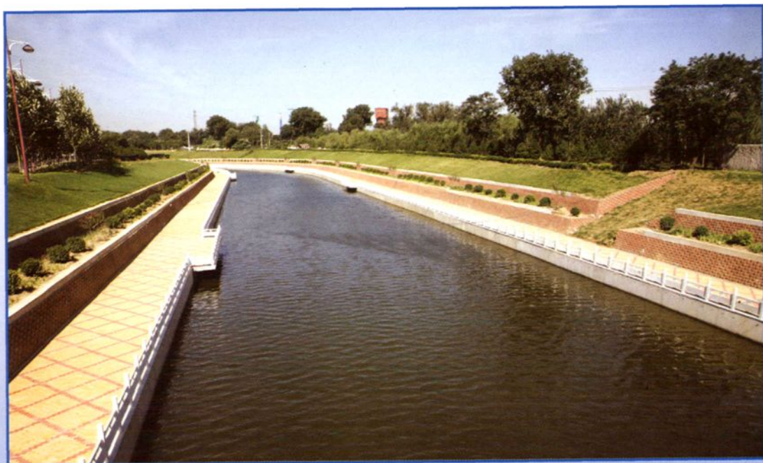
唐山市环城水系南湖生态渠工程
