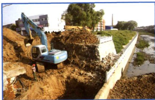
小青龙河道治理工程
