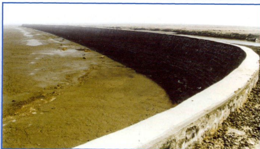
加固后的唐海段海堤
