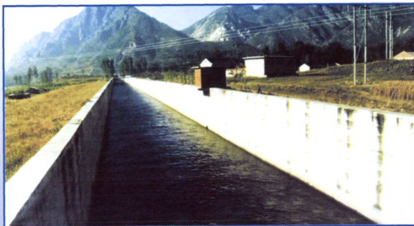
引滦入唐工程输水渠道
