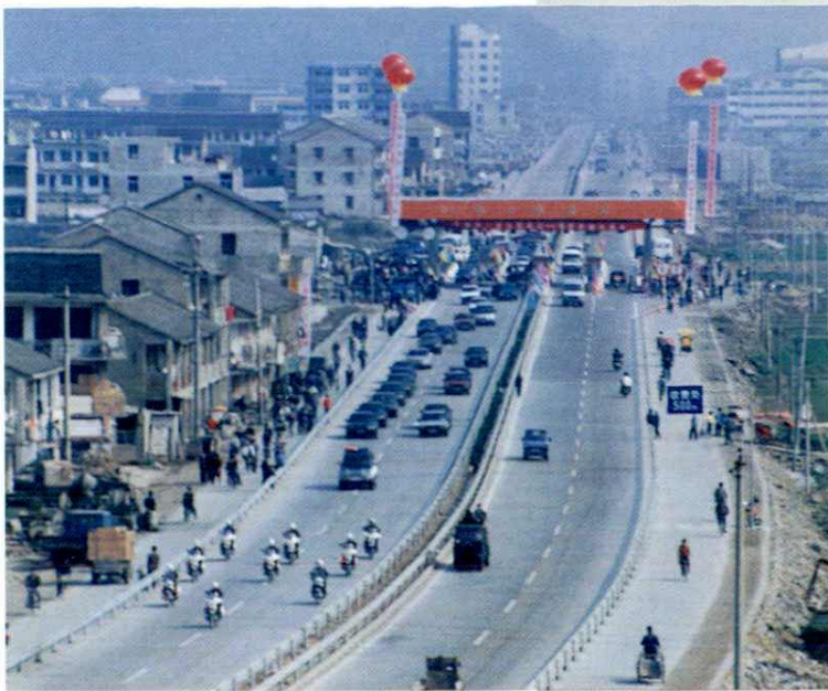
▲大环线拓宽工程建成
