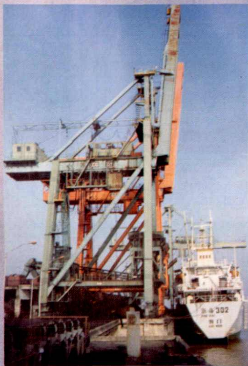
▲ 台州电厂煤码头
