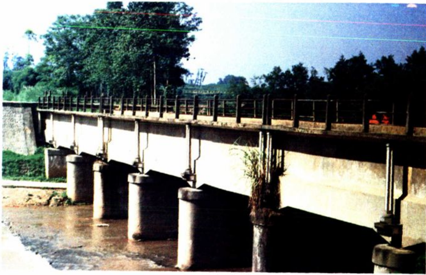
灌溉二十八万亩农田的水量通过通济堰西干渠毛河渡槽。
