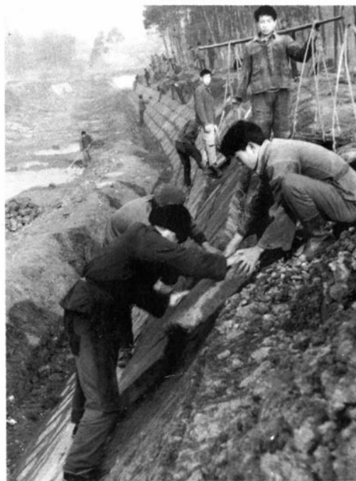
浆砌混凝土板渠道 衬砌护坡。
