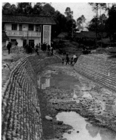
对渠道进行浆砌卵石 护坡衬砌。
