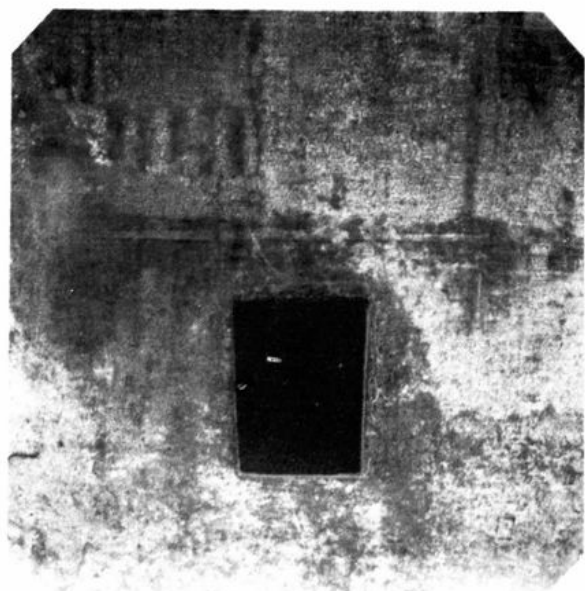
清代用生铁铸成的通济堰分水口 (图为彭山铁壁筒分水铁壁)
