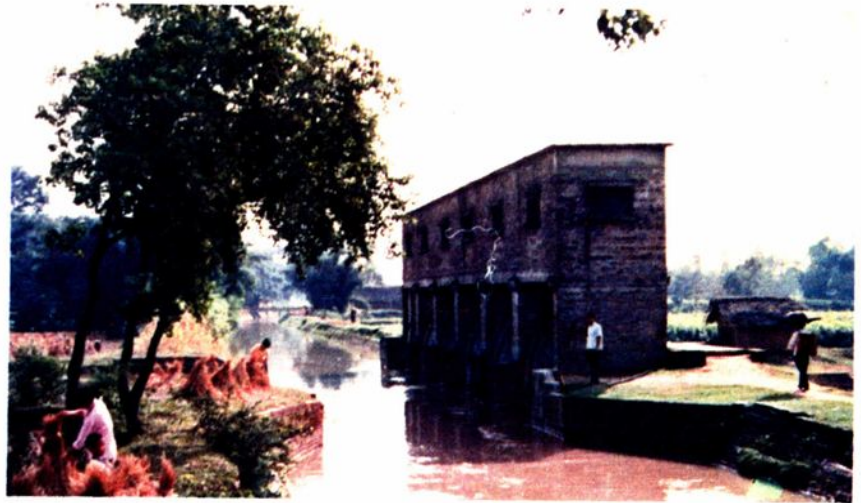
能排泄 135\text{M}^3/\text{S} 洪水的西干渠牛屎堰泄洪闸。
