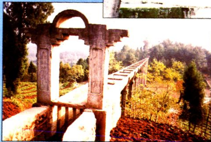
◀ 山虎关水库简村渡槽
