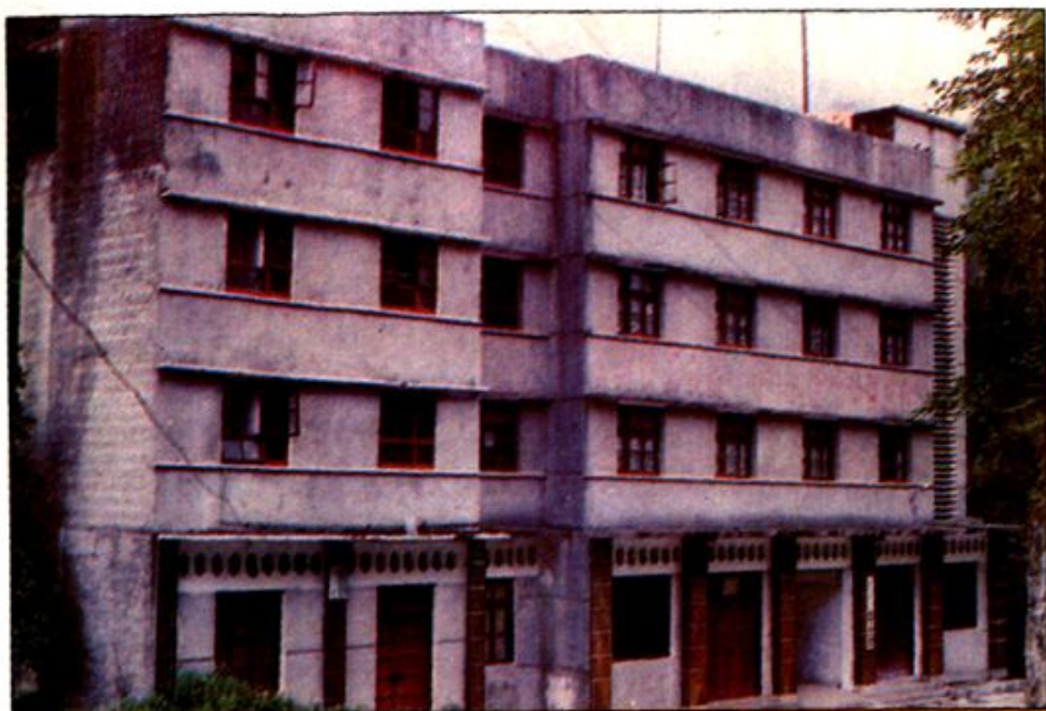
◀ 枢纽工程管理所
