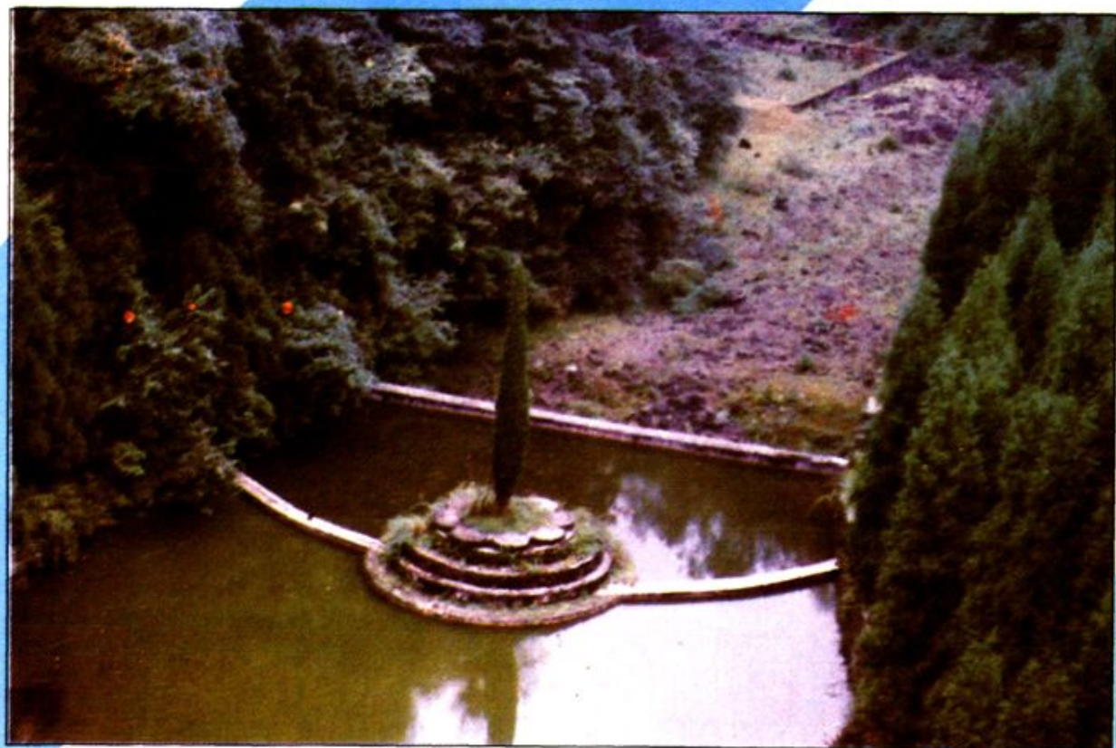
▲ 山虎关水库二坝
