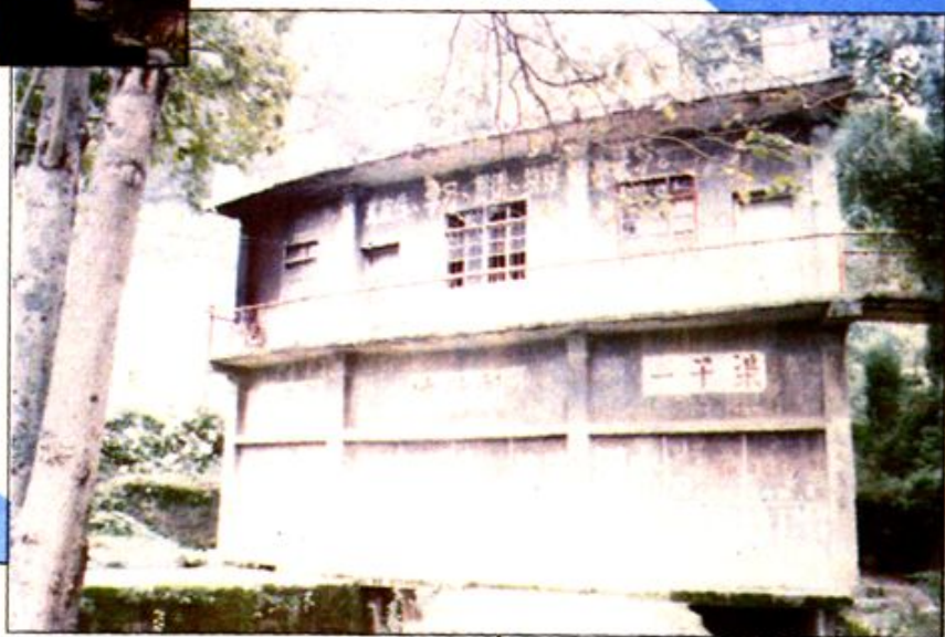
▼ 山尖石隧洞分水闸
