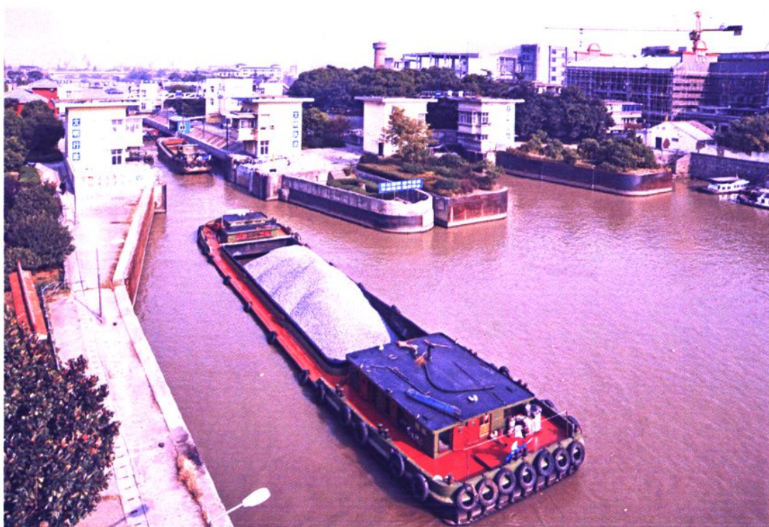
江阴二线船闸（1985年建）
