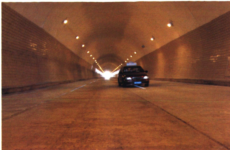
渤海大道南山隧道
