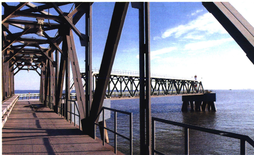
锦州港 25 万吨级油泊位
