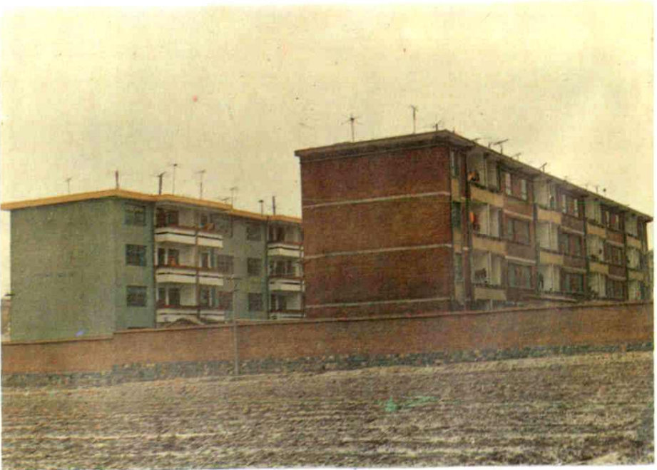
新建工程师宿舍楼
