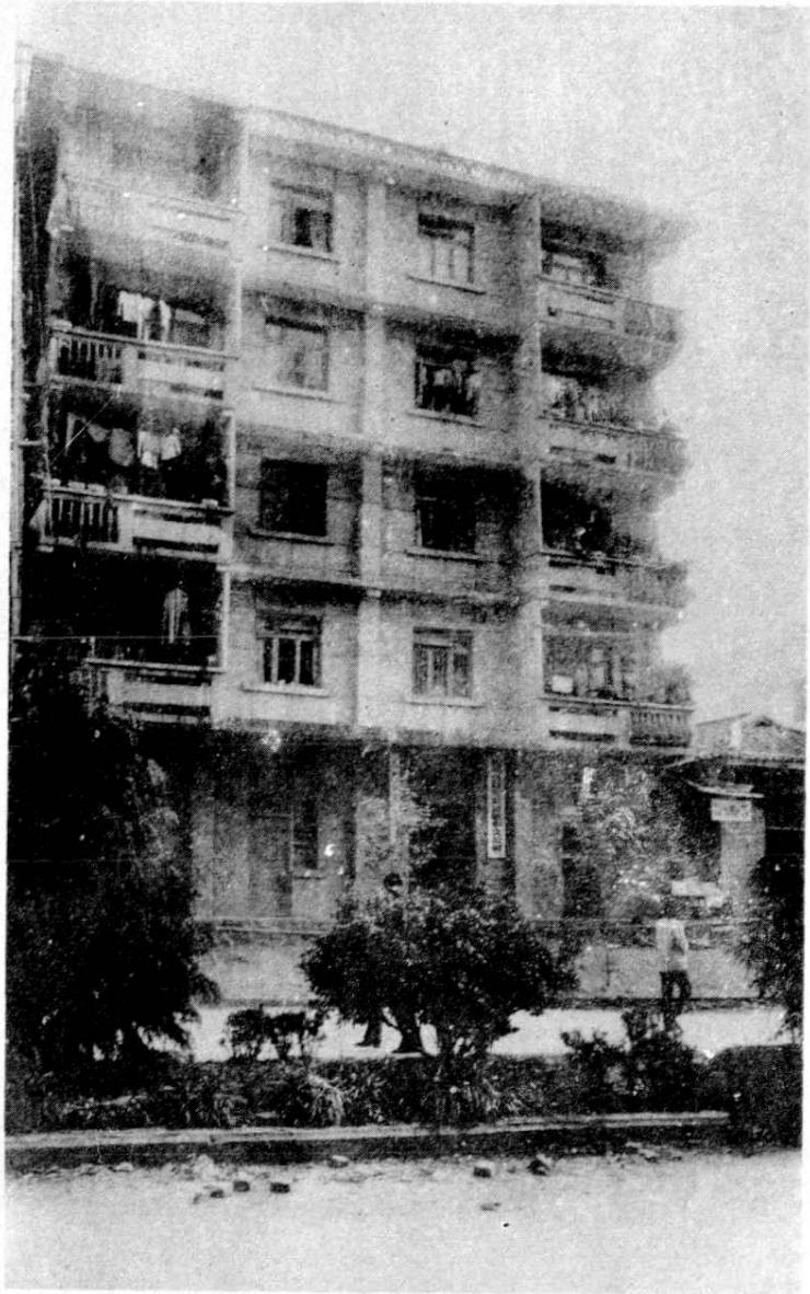
巴中县盐业支公司办公楼
