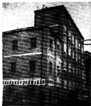
面粉厂制粉车间
