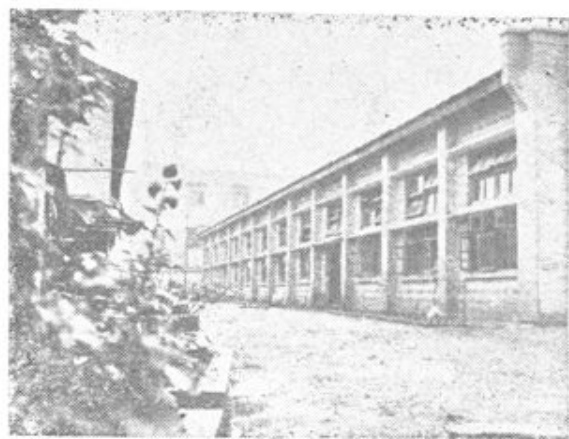
图2 内江市制钳厂新建车间
