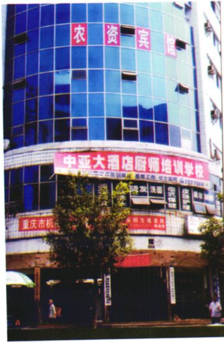
广安区供销合作社办公大楼
