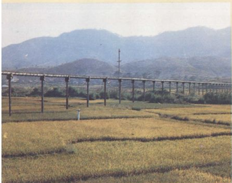
庐丰畲族乡民兵水库渡槽
