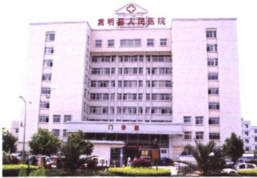
21世纪县医院门诊大楼
