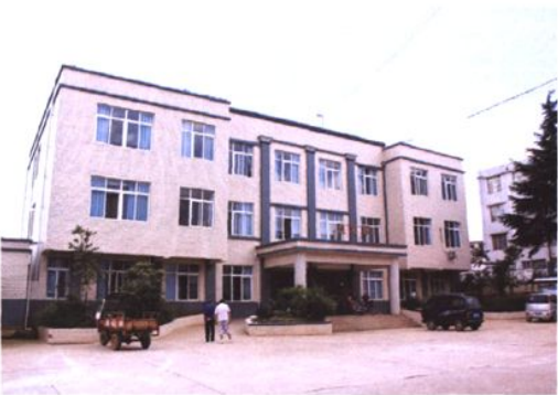
滇源镇卫生院住院部
