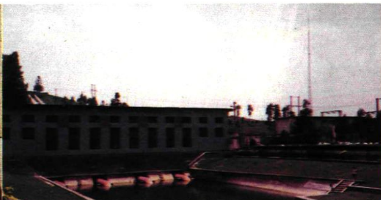
朱岗电力泵站
