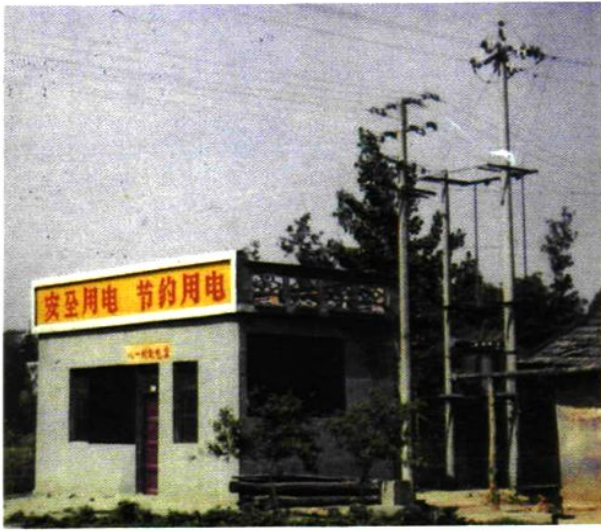
农村配电台区
