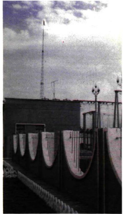
薛集变电站——湖北省首座 国产设备小型化站
