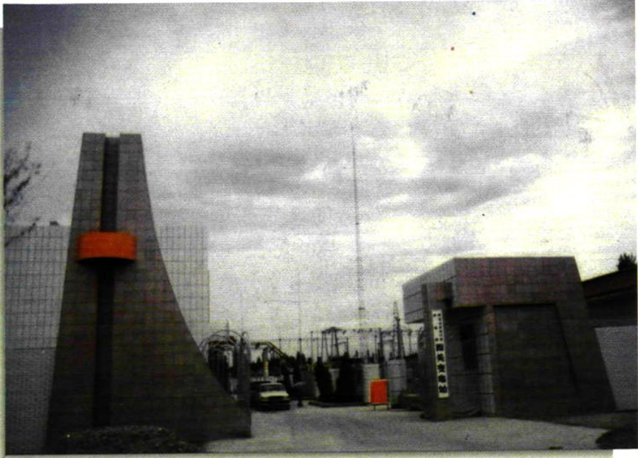
110KV 西关变电站
