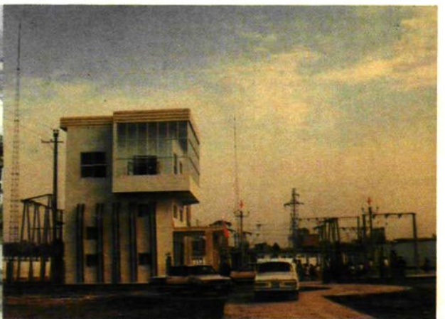
35KV 北郊变电站
