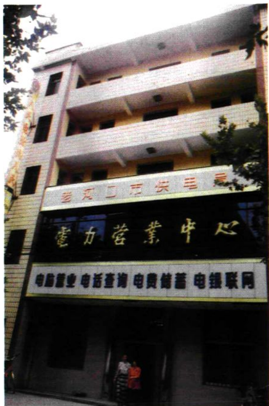
老河口供电局营业中心
