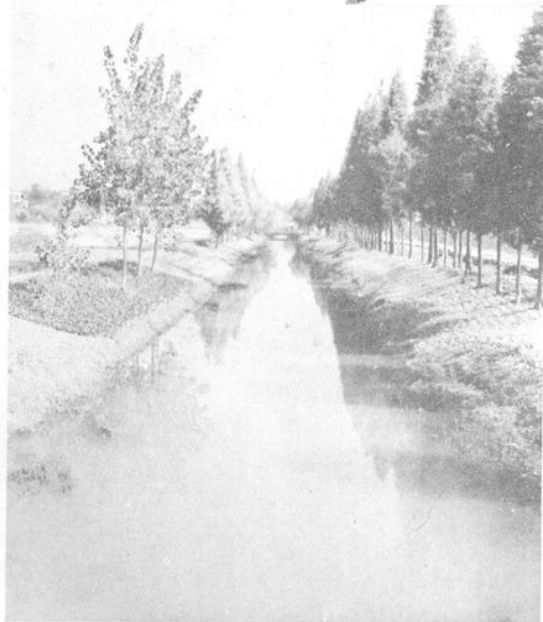
◀新建渠道一角
