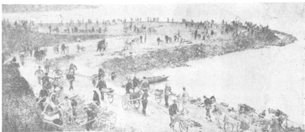
▼倒水改道工程中孔埠民工奋战在陶家大湖工地上
