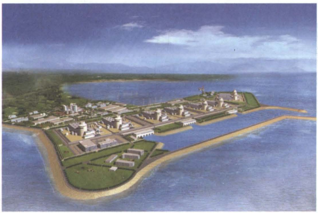
山东省分行支持的第三代核电项目——山东海阳核电项目
