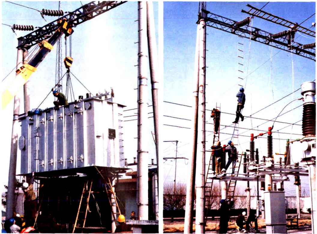
110 千伏武康变电所 2 号主变压器吊芯
