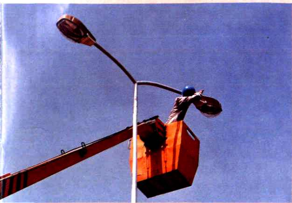
104 国道路灯维修
