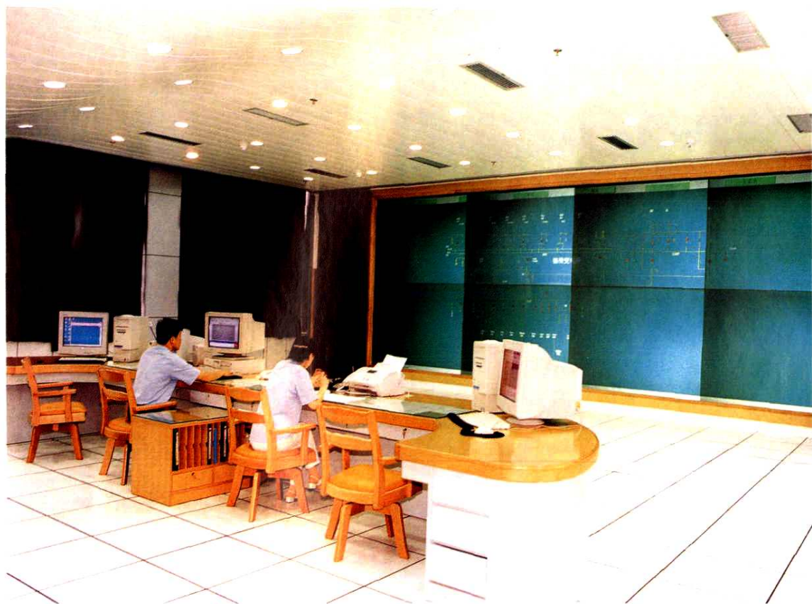
德清电网电力调度室
