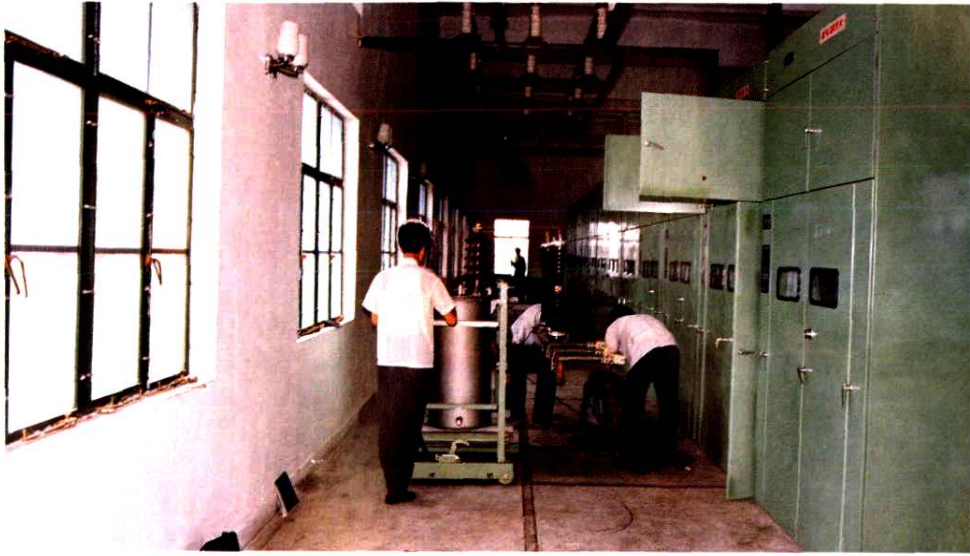
110 千伏新市变电所 35 千伏 2 号所用变压器检修
