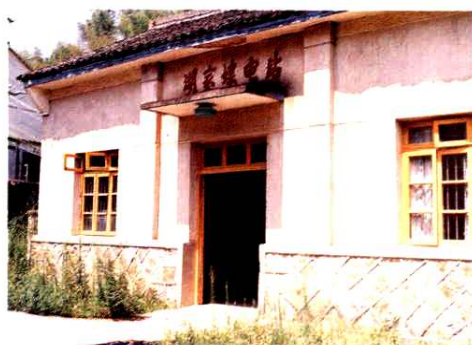
南路乡湖家埭小水电站厂房一角
