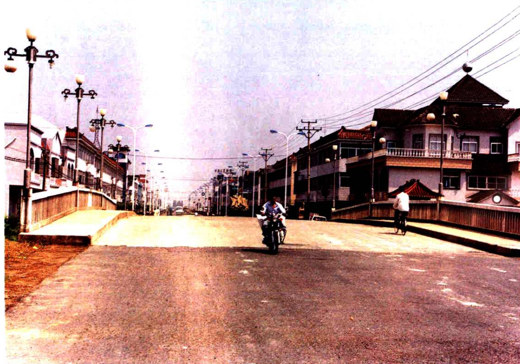
钟管镇新街10千伏、380/220伏线路装置
