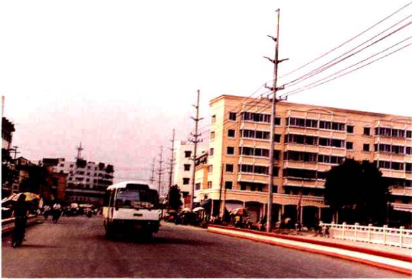
武康镇采用钢质电杆高低压线路同杆架设
