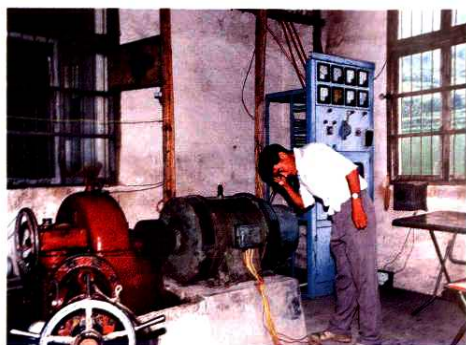
后护村小水电站 55 千瓦发电机组
