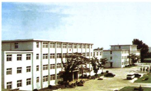
▲ 中共深南县委、深南县人民政府办公楼
