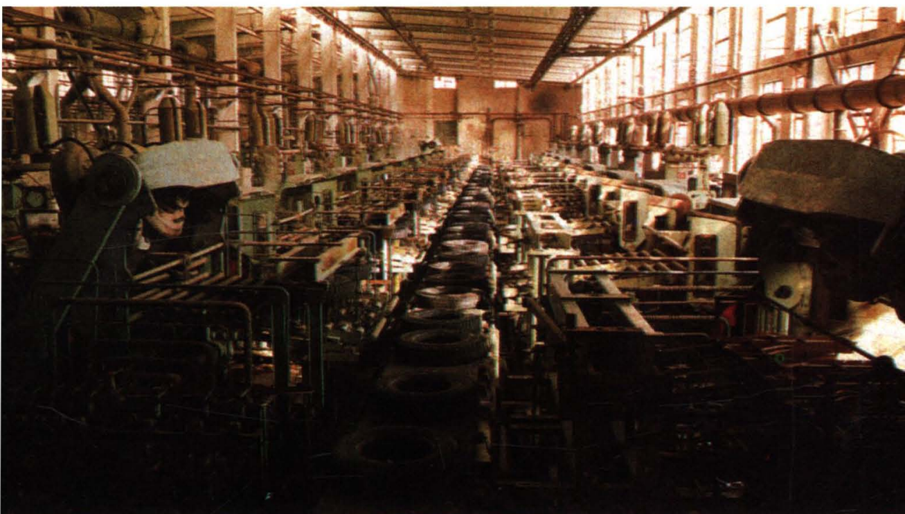
六十年代轮胎大会战中在新建河南轮胎厂安装的双模定型硫化机群及成品自动运输线和铁路专用运输线
