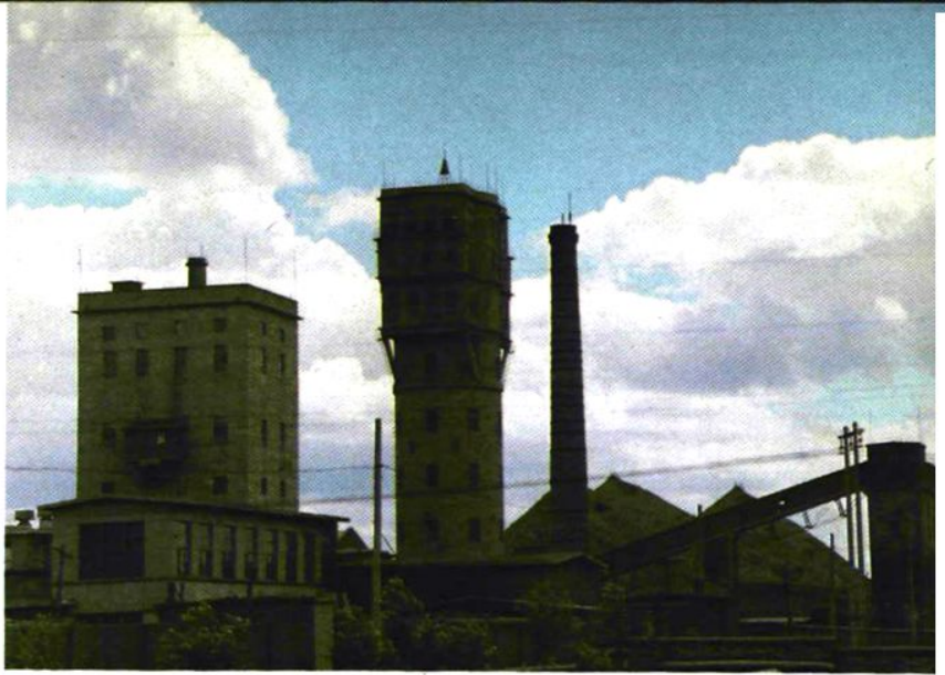
▶ 台吉千米竖井地上部分外景 韩伟摄
