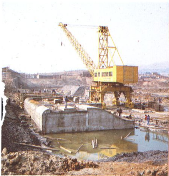
施工中的水晶岗水电站
