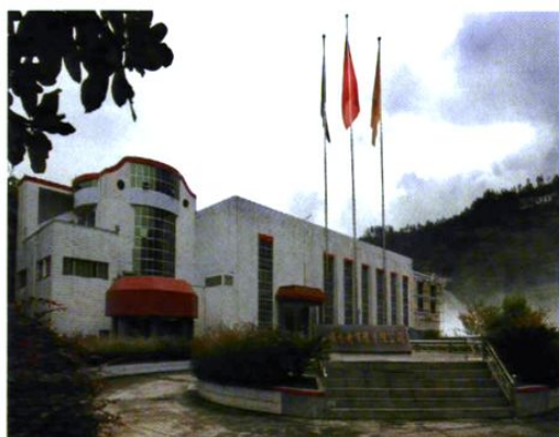
1999年3月建成的主厂房，占地面积1813平方米
