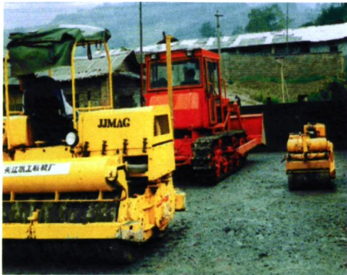
1998年4月，碾压混凝土施工
