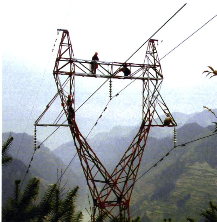
咸（丰）长（顺）110千伏输电线路维修（2006年3月）
