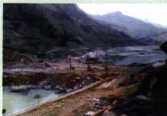
1996年3月，下游围堰施工
