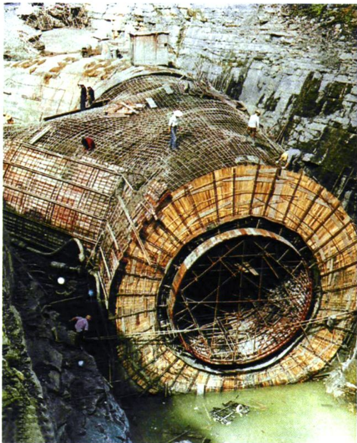
1997年10月~1998年6月，进行中的发电岔管浇筑
