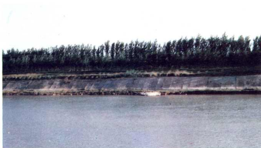
唐河护岸工程
