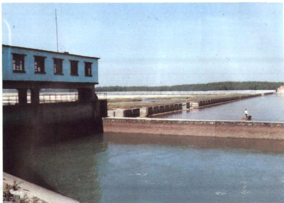
大占头引水枢纽近景
