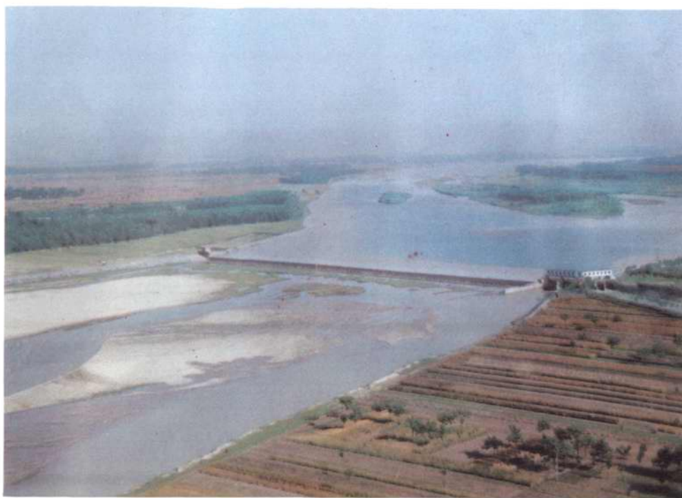
鸭灌白桐干渠大占头引水枢纽
