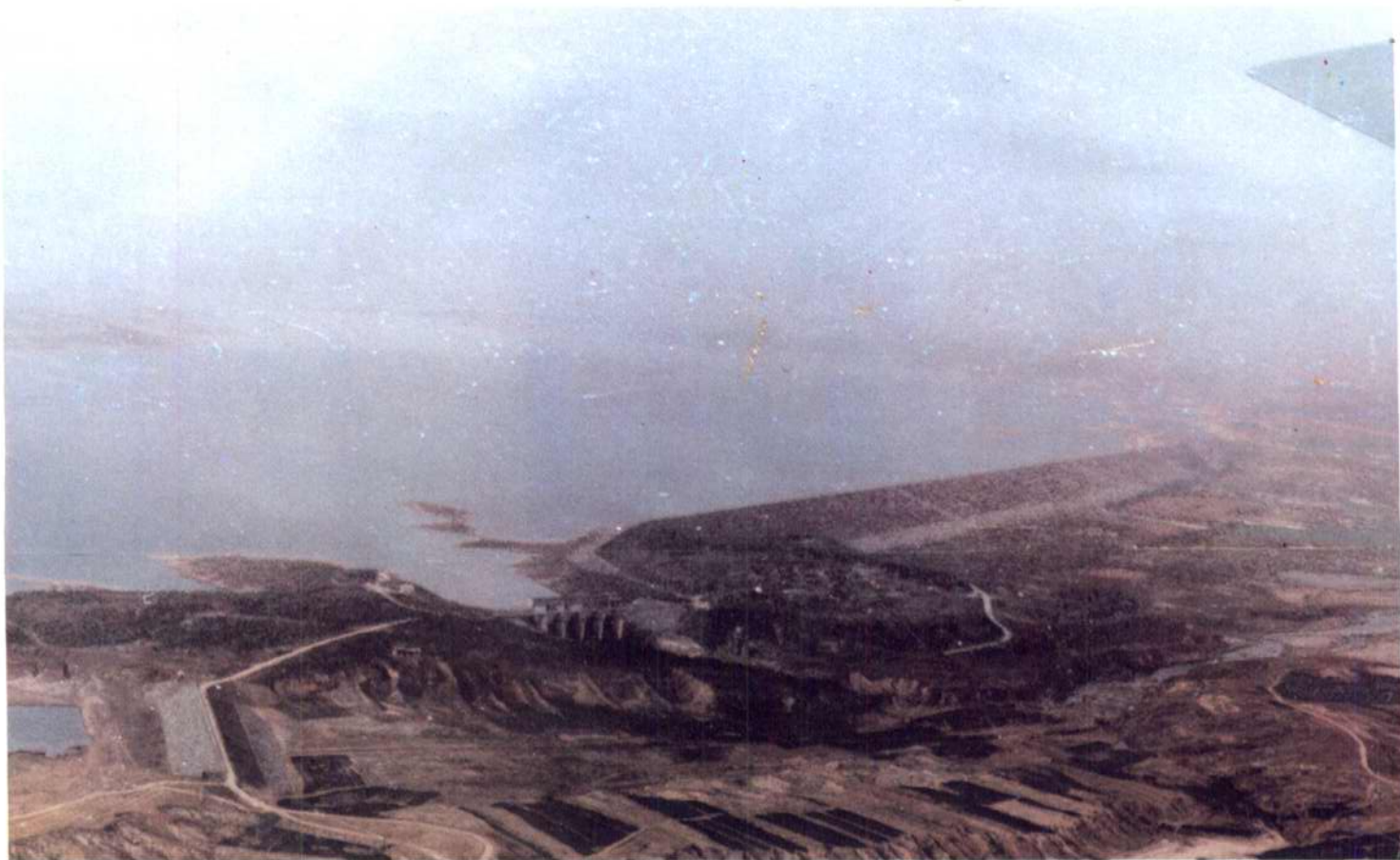
鸭河口水库全景
