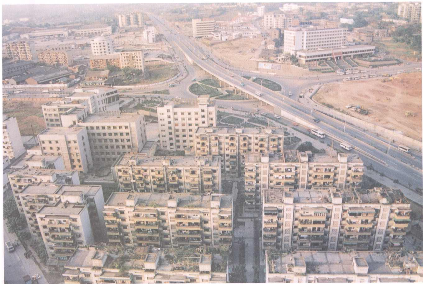
建设中的江北开发区城市道路
