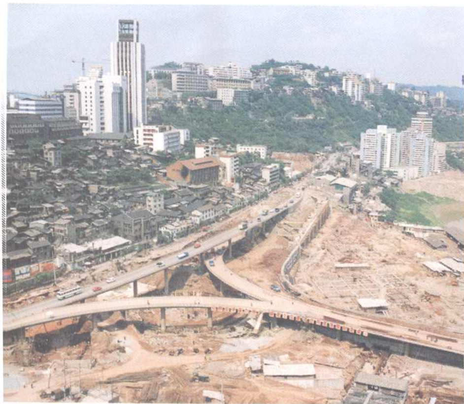
建设中的菜园坝车行立交道
