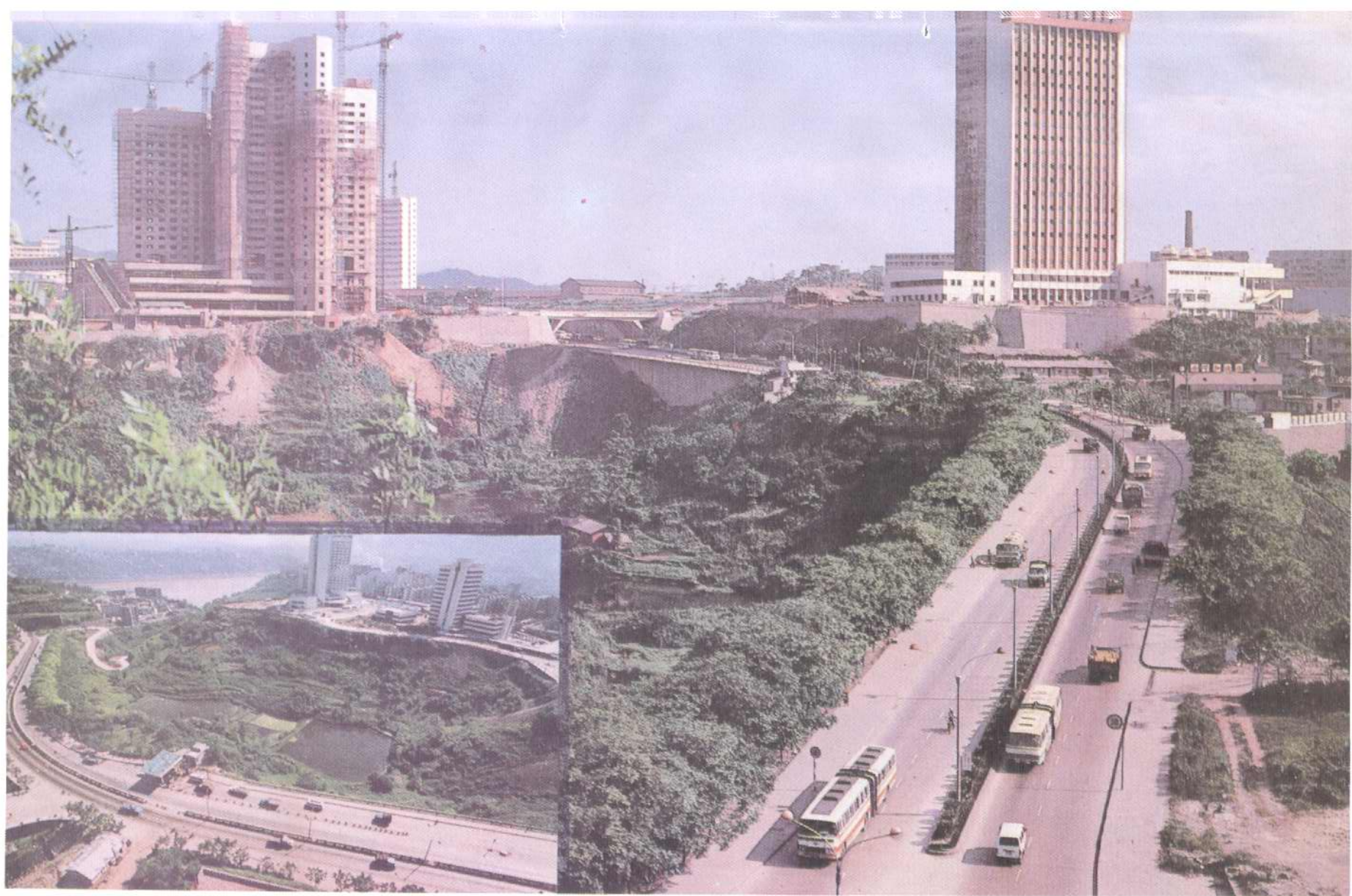
建设中的南坪开发区城市道路
