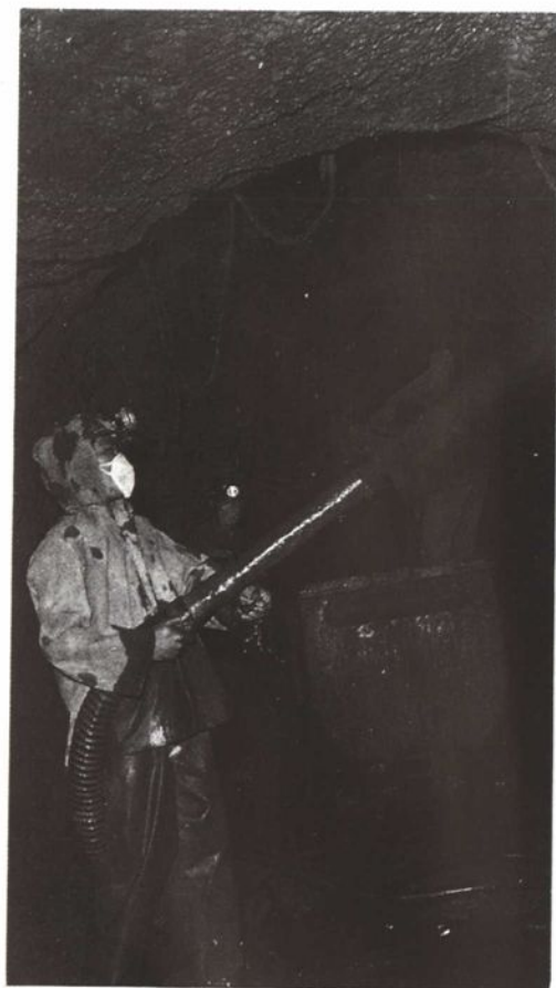
◇ 更班矿西大巷锚杆喷浆
