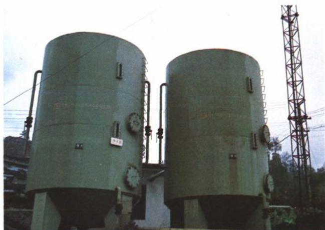
更班矿井下废水治理工程
