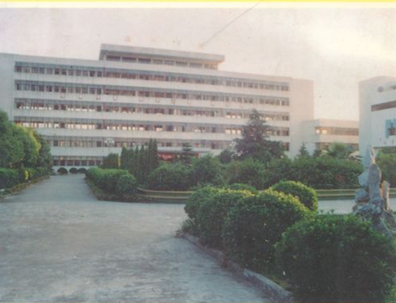
浙江省温州商业学校教学大楼
