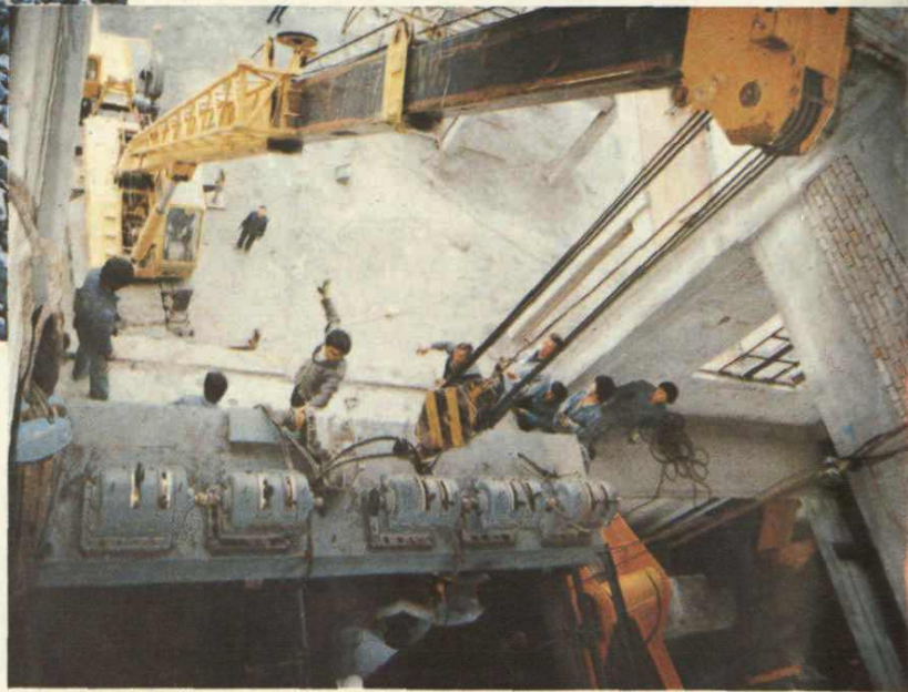
矿自建洗煤厂正在安装设备，投产后年 入洗能力为15万吨
