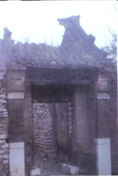
修缮前的东瓦大门
