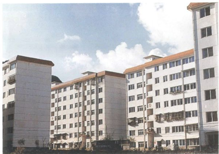
◀ 兴义化工总厂北门 职工住宅区
