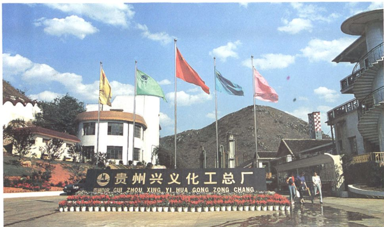
▲贵州兴义化工总厂大门
