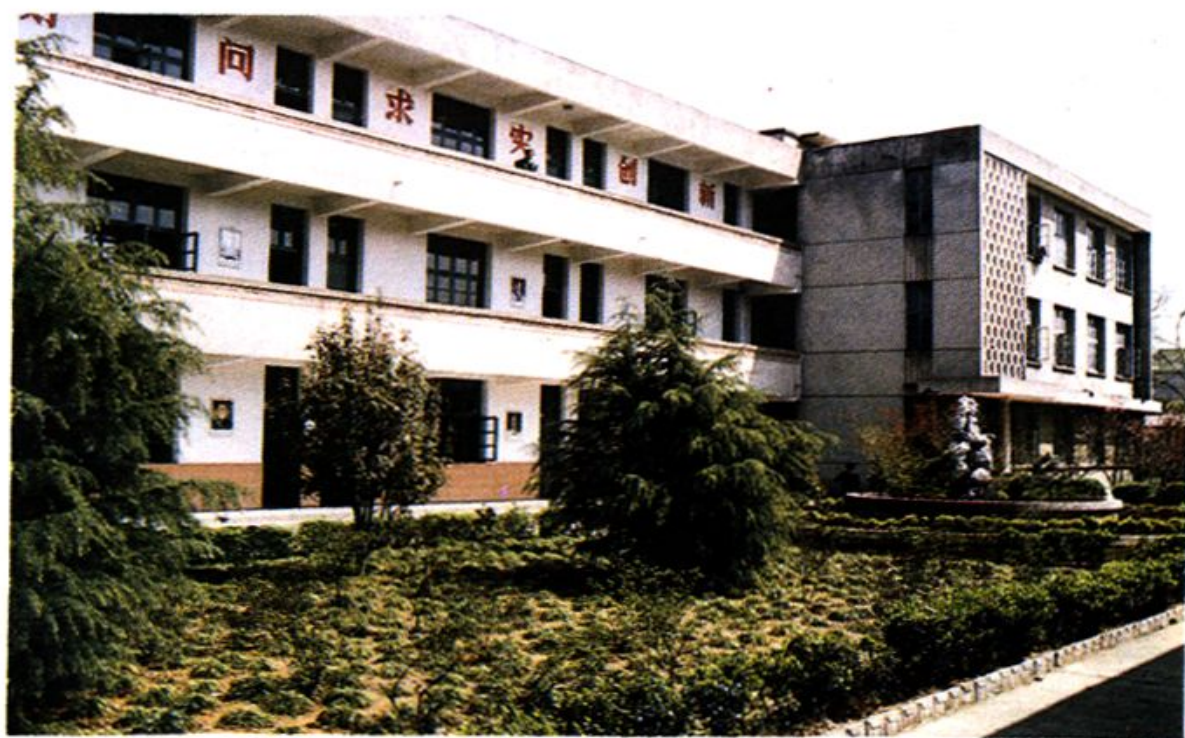
半山路小学教学楼。
