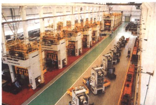
武汉东风冲压件有限公司厂房一角
