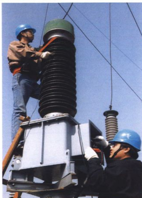
110千伏扬中变电 所改造施工现场
