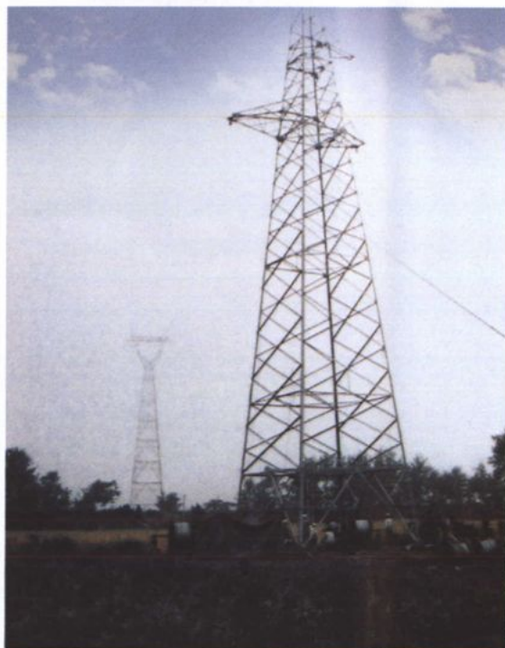
110千伏石坊线大跨工程扬中段主锚塔施工
