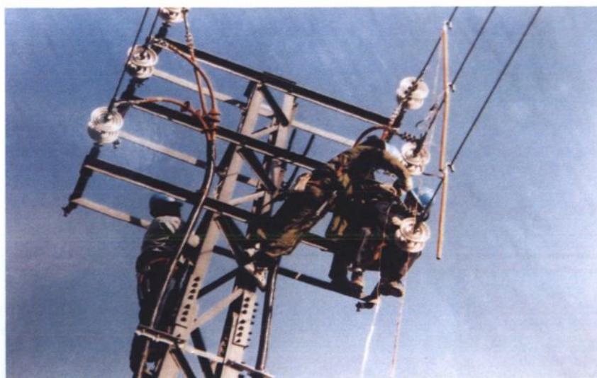
35千伏联合变电所 改造10千伏出线施工
