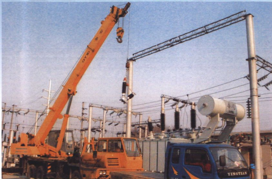
110千伏油坊变电所1号变压器更换施工
