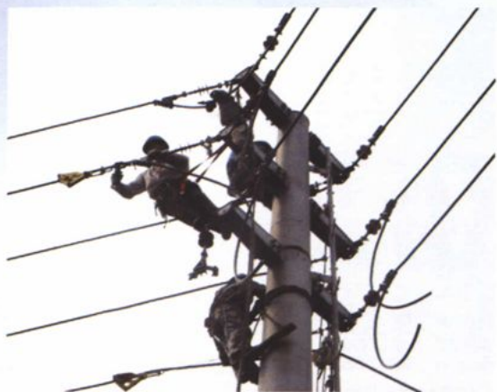
扬中市电网改造施工现场
