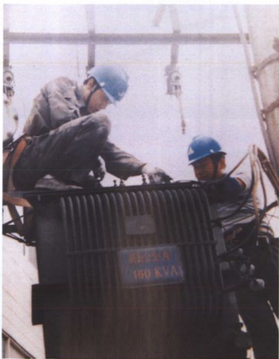
扬中市供电局配电检修小组在检修变压器
