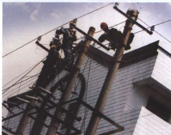
扬中城网改造现场
