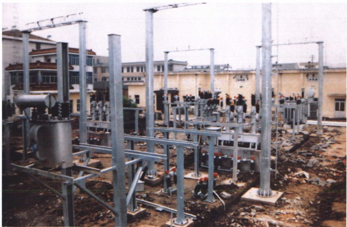
改造中的35千伏长旺变电所
