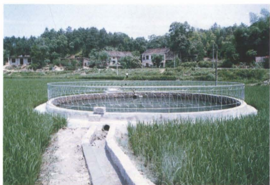
▲ 大塘良繁项目区抗旱井工程
