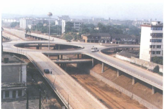
▲ 主体工程完工的西外环华新立交桥
