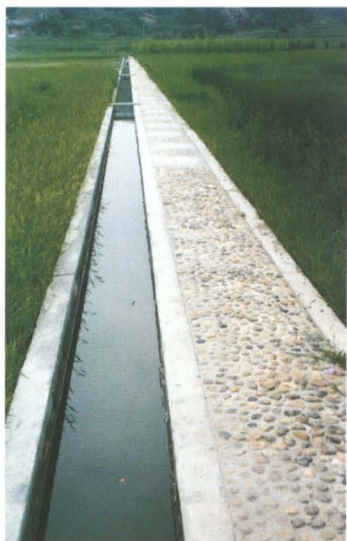
◀ 路渠结合工程
