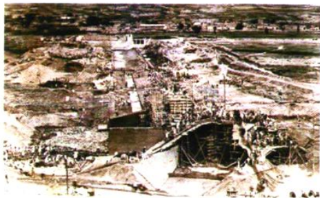
1950年榆次潇河大坝建设工地
