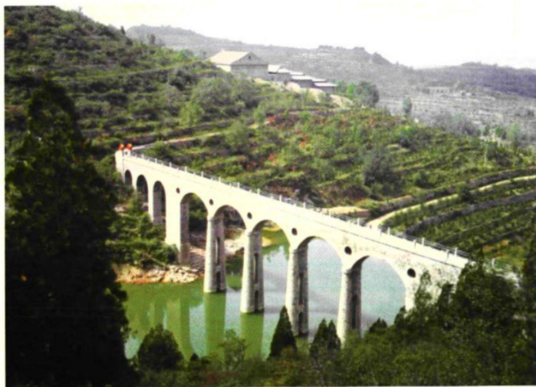
大寨团结沟渡槽
