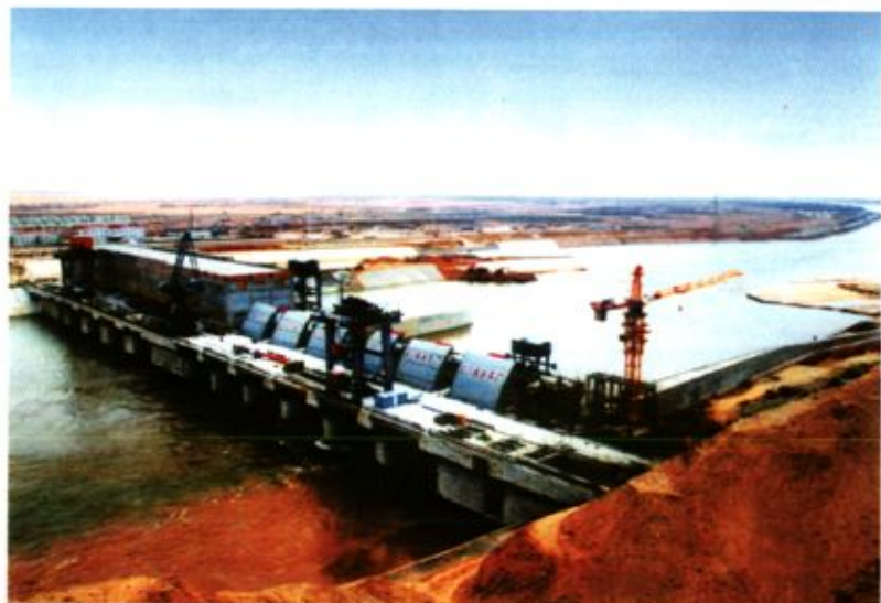
涉及宁夏、甘肃、陕 西三省区的盐环定扬水 工程共用部分于1997 年竣工,图为泵站机房。
