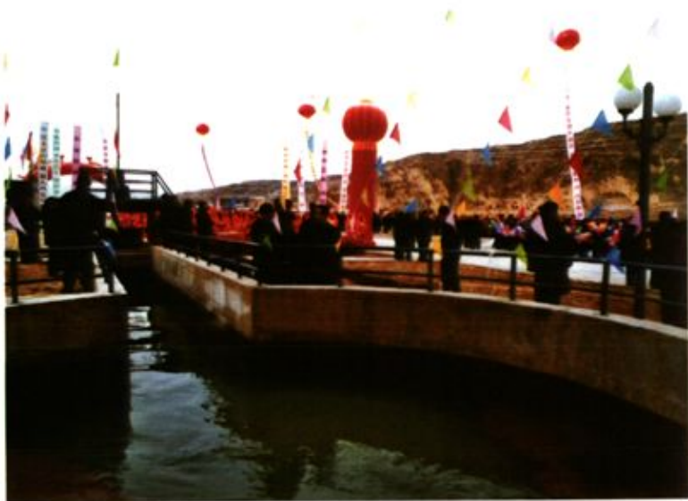
彭阳县长城塬引水 工程于 2003 年 12 月建 成，图为泵站进水前池。
