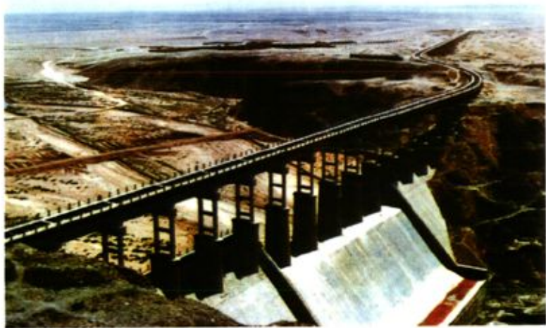
1986 年底竣工的 固海扬水工程，图为跨 长山头渡槽。
