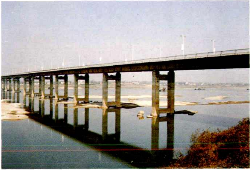
常德市沅水预应力连续梁桥全长 1408米
