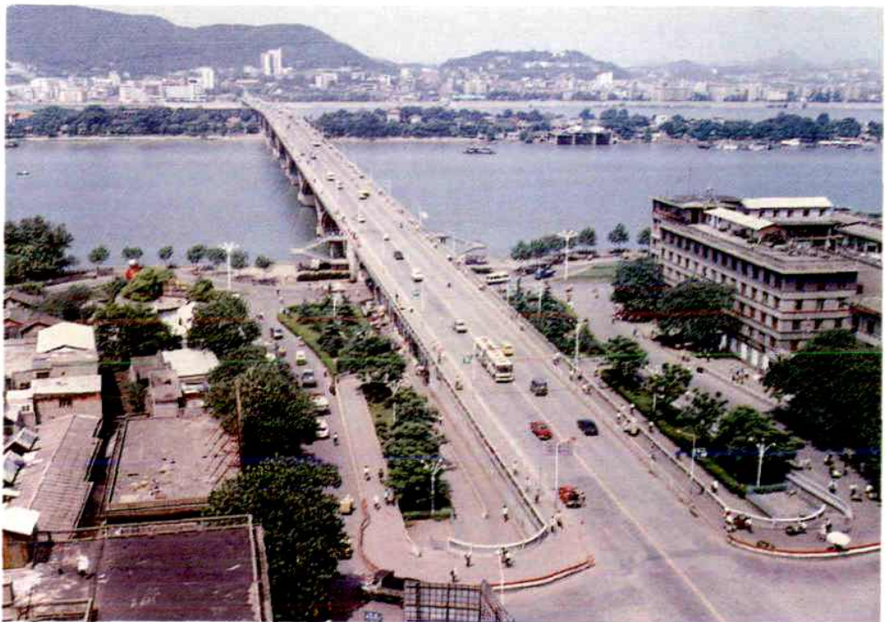
长沙市湘江一桥为双曲拱桥，主桥全长1250米
