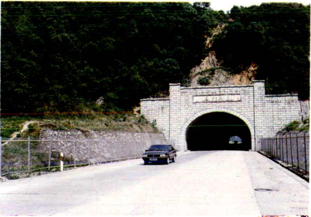
莲(花冲)易(家湾)一级汽车专用公路建宁隧道
