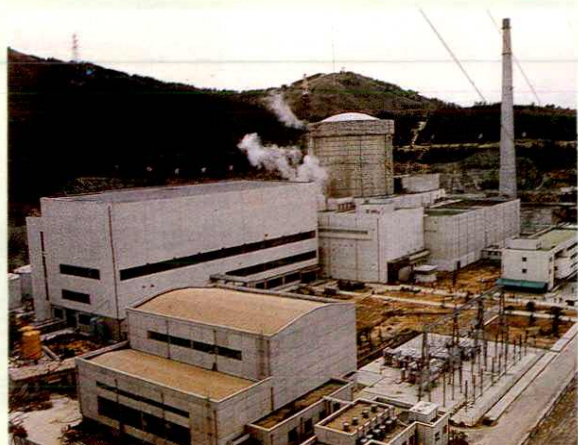
秦山核电站全景
