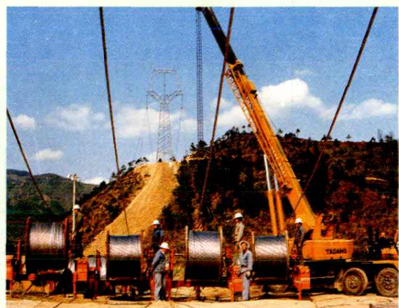
500 千伏密南线张力放线
