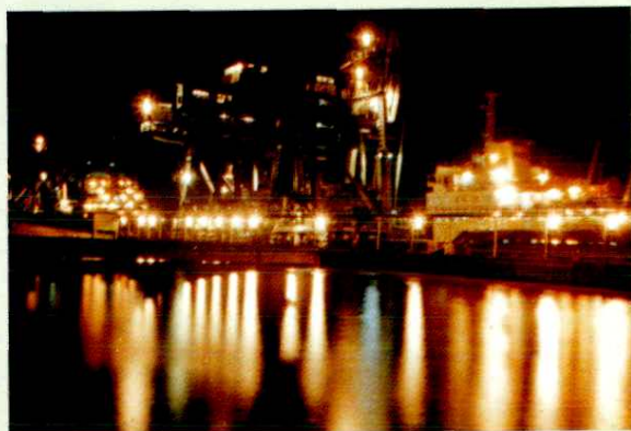
台州发电厂万吨级煤码头
