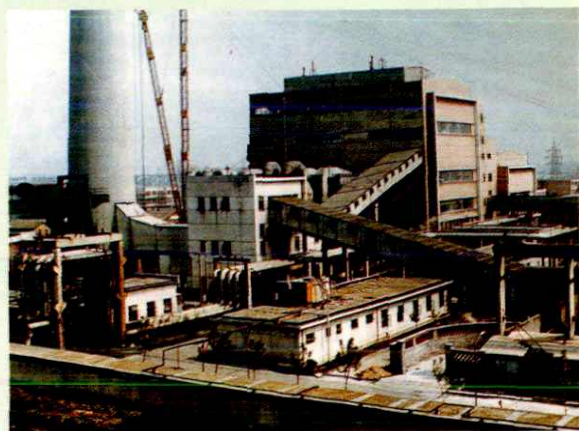
联片供热——杭州热电厂
