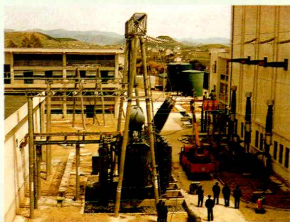
安装中的 110 千伏舟山直流输电逆变站的换流变压器、 阀厅及滤波装置
