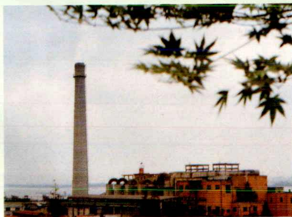
老厂新貌——建于 1932 年的闸口发电厂
