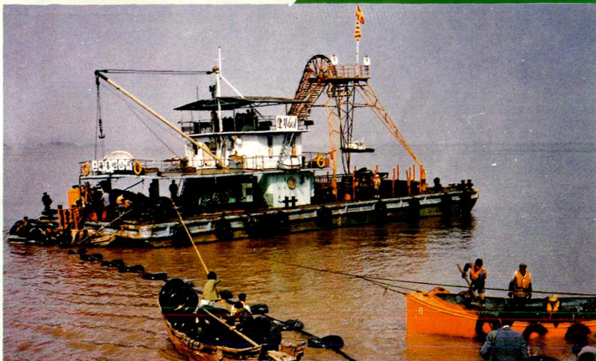
100 千伏舟山直流输电工程海底电缆敷设
