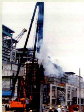
1986 年 11 月 13 日镇海发电厂三期工程打下第一根钢筋混凝土桩
