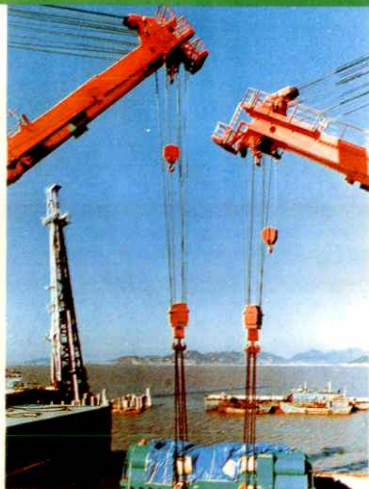
北仑港发电厂工程建设中 300 余吨重的发电机定子卸船
