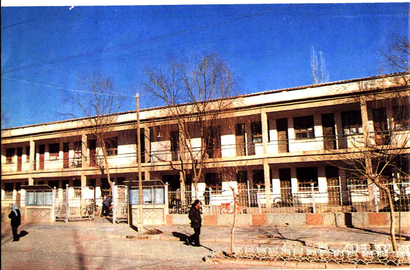
青铜峡供电所
