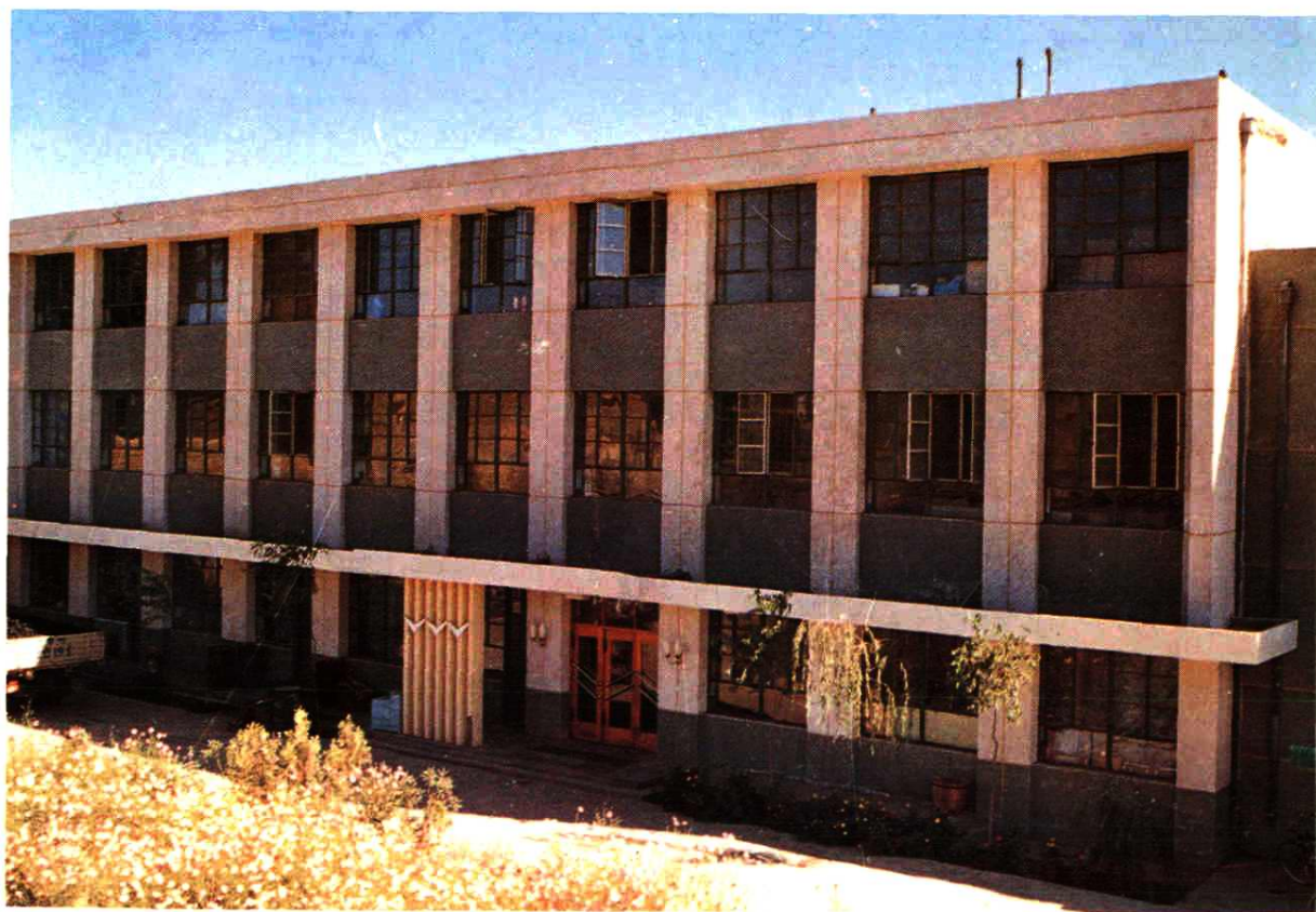
变电工区办公楼
