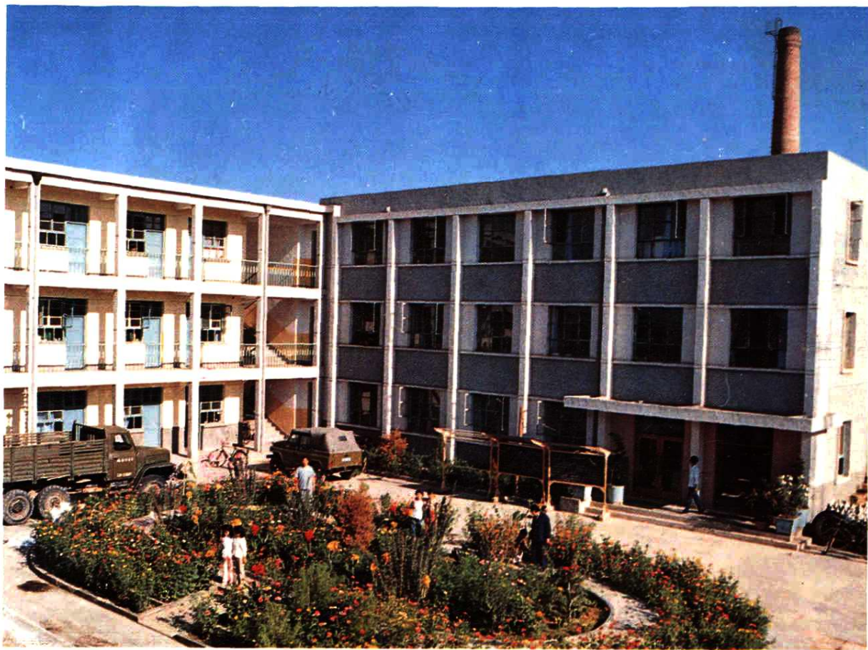
送电工区办公楼
