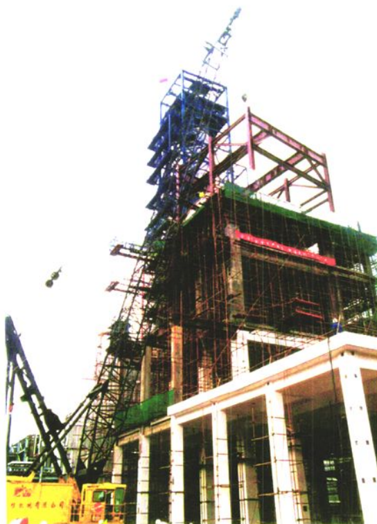
装置大修现场（2002 年）
