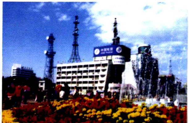
临汾邮电大楼(1998年)
