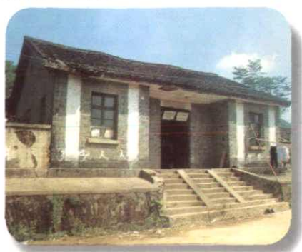
烈桥邮电所旧房
