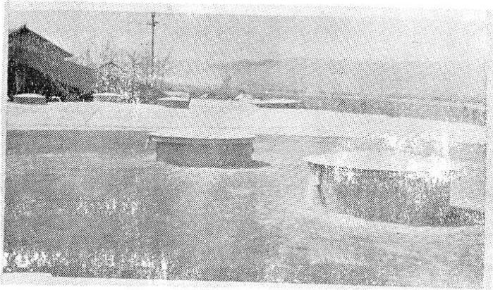
图九、地下仓加固层和进粮口
