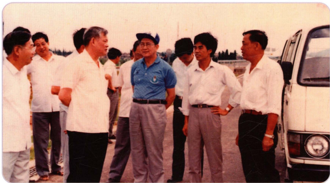
1988年，广佛高速公路通车典礼时，省长叶选平（前左二）、副省长匡吉（前右三）视察湛江公路局第一工程处大沥立交大桥工地
