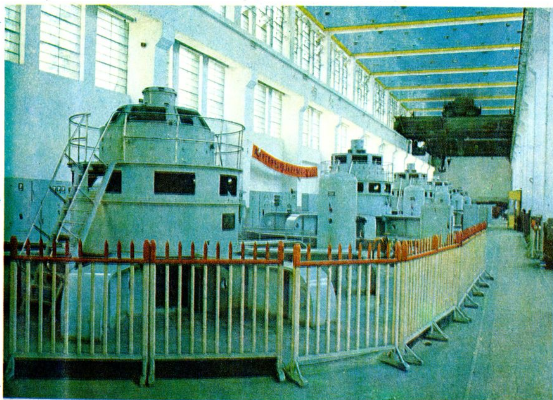
柘溪电站水轮发电机组
